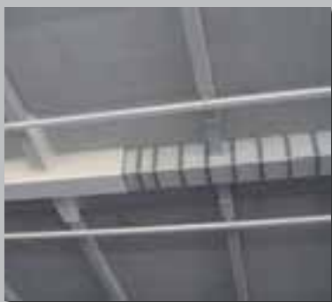
Lieferung und Montage von Brandschutzbekleidungen und Brandschottungen.
