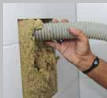
Hohlraumfreie Befüllung von Installationsschächten in Brandschutzqualität (F90).
