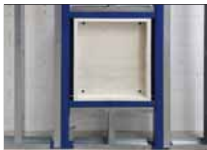
Montierter Einbaurahmen KS-ER mit Innenbeplankung
