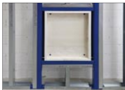
Montierter Einbaurahmen KS-ER mit Innenbeplankung
