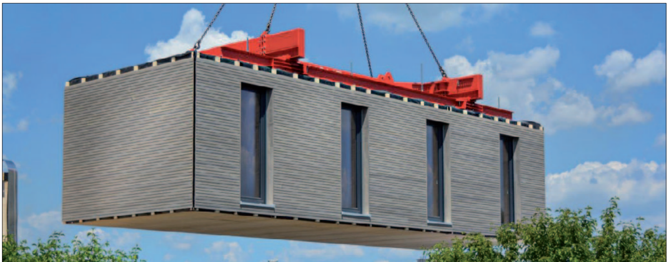
Modulares Bauen 1: Komplette Wohneinheiten.
