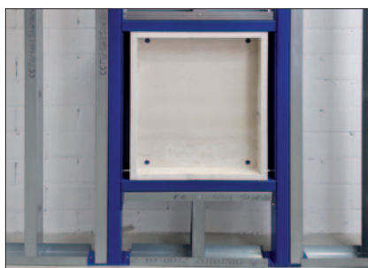
Montierter Einbaurahmen KS-ER mit Innenbeplankung
