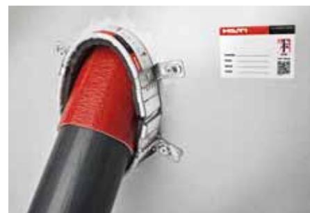
**Beschreibung:** Schräg durchgeführte Rohre können in Leichtbauwänden, Massivwänden und Massivdecken verwendet werden. Die Neigung muss zwischen 45 und 90 Grad liegen, wie in der folgenden Abbildung dargestellt:
