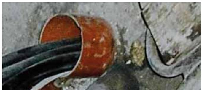
Hüllrohr bündig mit Wand/Decke abschneiden.
