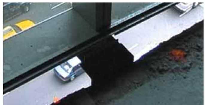
Offener Spalt zwischen Fassadenelement und Decke.
