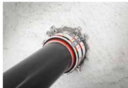
**Beschreibung:** Rohre mit einem größeren Durchmesser als 110 mm, die durch Massivwände und -decken geführt sind, müssen mit zwei Hilti Brandschutzmanschetten Endlos CFS-C EL abgeschottet werden.
