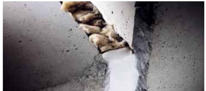
Brandschutzdichtmasse CFS-S SIL/CFS-S ACR.
